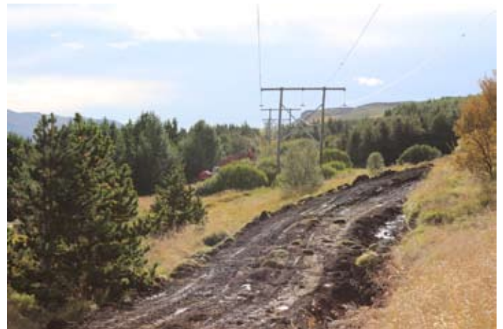
Nýr vegslóði á Gunnfríðarstöðum. Júlíus Línal verktaki sá um vegalagninguna (Mynd: Páll Inghór Kristinsson).
