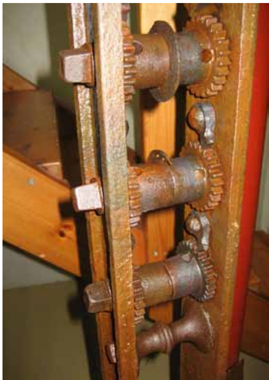
6. mynd. Eftir meira en 100 ár var strekkibúnaðurinn á kraftstaurnum enn svo til heill. Mynd: BG
