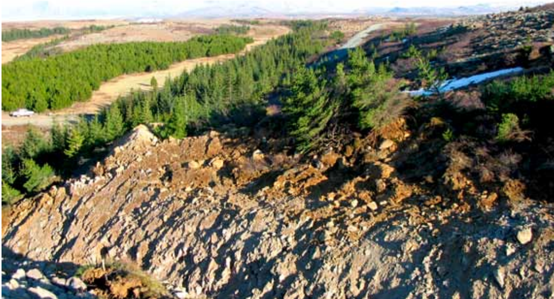
Yfirlit yfir skemmdirnar við vatnsveitulögn Kópavogsbæjar í Heiðmörk.
