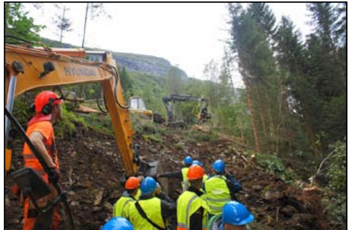
Skógarhögg í Skredestranda. Eins og sjá má stendur skógurinn í snarbrattri hlíð. Við slíkar aðstæður eru iðulega notuð timburspil til að flytja afurðirnar úr skóginum, en vegna raflínu var það ekki hægt þarna og því notuð beltagrafa til að útbúa slóða fyrir skógarhöggs- og útkeyrsluvélar (Mynd: EG).
