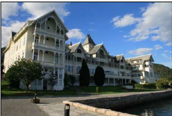
Kviknes Hotel í Balestrand. Það er eitt stærsta hótél Noregs, með 190 herbergi, en auk þess er það ein stærsta timburbygging landsins, alls 8.000 m 2 . Það var valið „Besta sögulega hótelið við vatn 2014“ (Best Historic Hotel of Europe by the Water) af samtökum evrópskra sögulega hótela (Historic Hotels of Europe) (Mynd: Laufey B. Hannesdóttir).
