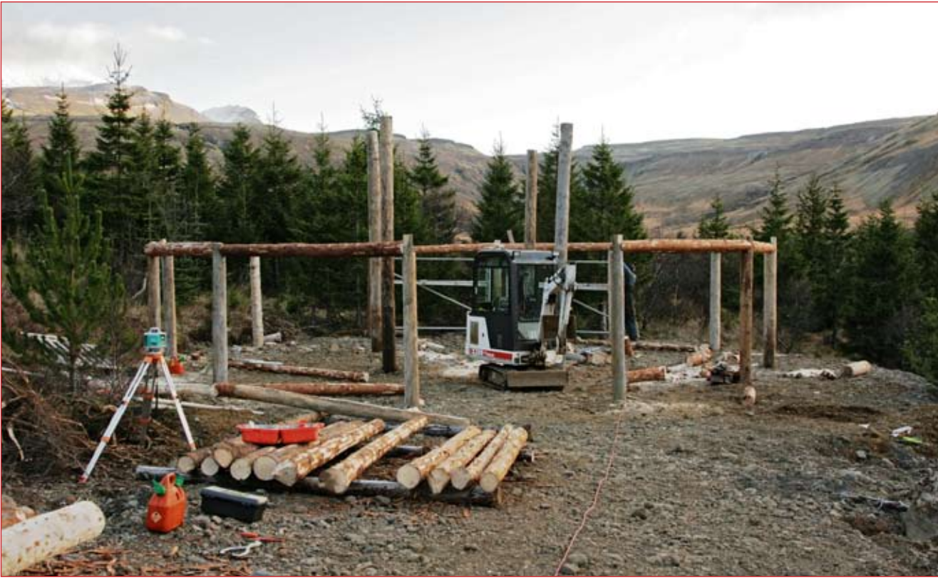
Sléttað var undir húsið og settur þunnur malarpúði. Burðarsúlur voru sóttar til Strandamanna, sem fengu væna sendingu af saltmarineruðu lerki frá vinum okkar Rússum (Mynd: RF).
