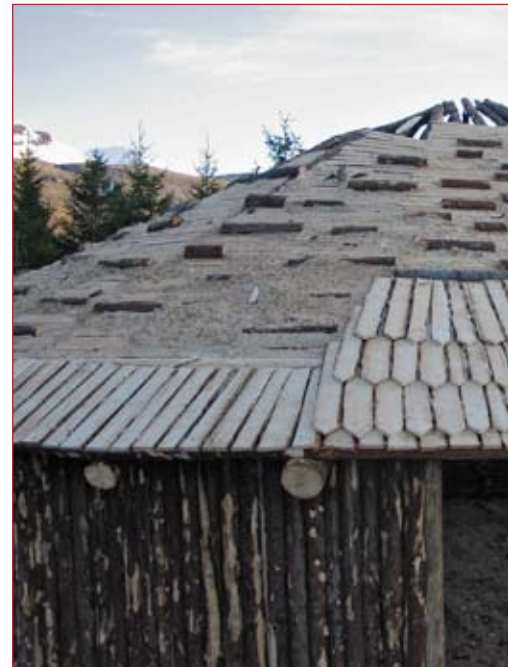
Þakið að taka á sig mynd (Mynd: EG).
