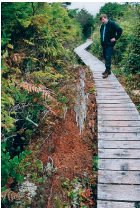
Verklegar framkvæmdir, svo sem byggingar, stígar, brýr og vegir, á skógivöxnum útivistarsvæðum í þéttbýli eru skipulagskyldar samkvæmt lögum. Myndin er frá Kanada og sýnir göngustíg um viðkvæmt mýrlendi.
