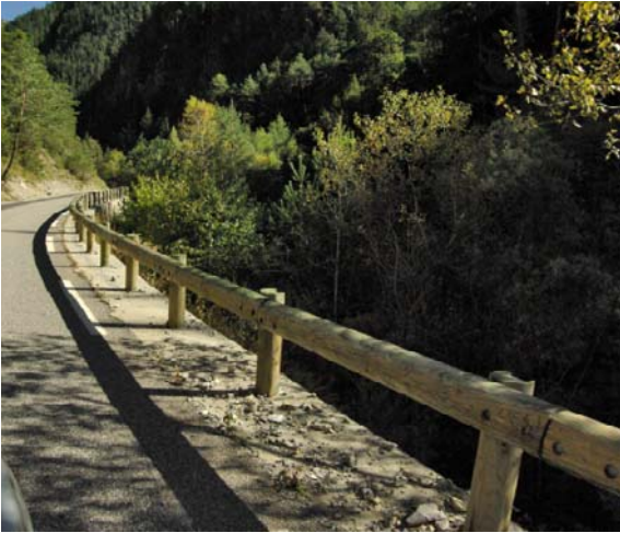
Timbur er í gríðarlegri sókn sem byggingarefni í Frakklandi og hvers konar not eru fundin upp og prófuð. Öll vegrið sem bar fyrir augu okkar í fjallabéruðum voru gerð úr bergfurubolum. Mynd: Brynjólfur Jónsson.
