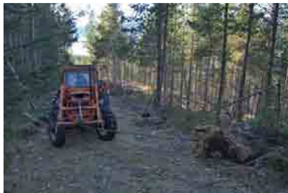
Dráttarvél notuð við að draga rætur upp á veg.
