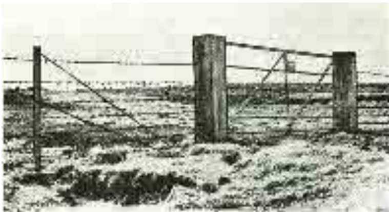
Mynd 6. Myndin sýnir aflstólpa sem strengt er í við hlið. Stagið úr honum er tengt í hliðsökkulinn. Ennfremur sjást festingarjárn á hliðstöpli.
