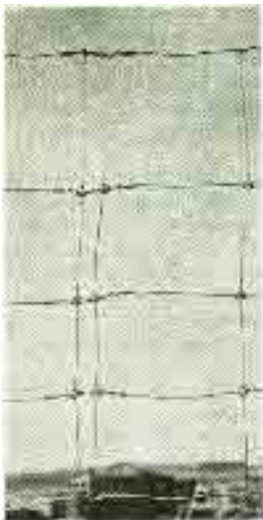
Mynd 12. Rétt skeyting á vírneti.
