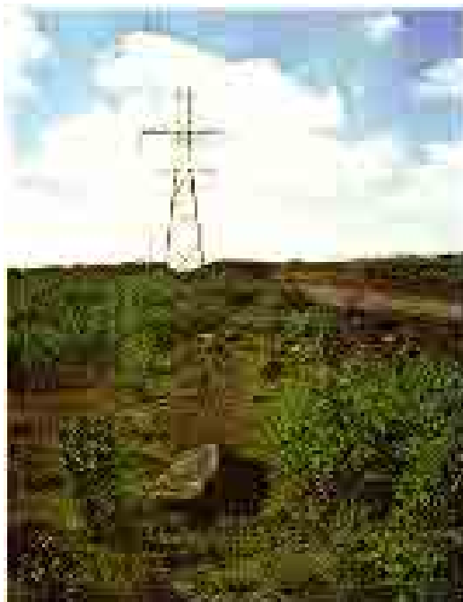
Háspennuturn á Heiðmörk í 220 kílóvolta Straumsvíkurlínu. Ljós.: Vilhjálmur Sigtryggsson 1974.
