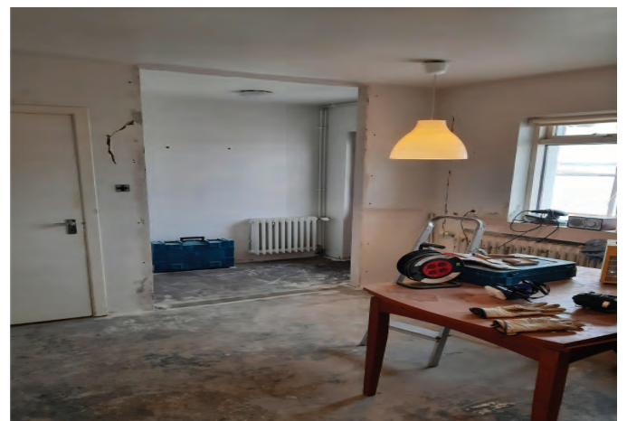
Búið er að rífa hluta af vegg í gamla bænum í því skyni að stækka eldhúsið enda oft margt um manninn við eldhúsborðið (Mynd: NH).
