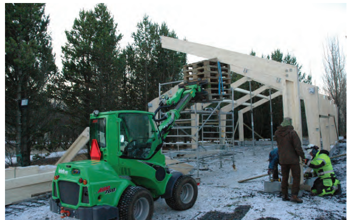
Liðléttingur Skógræktarfélagsins kemur í góðar þarfir við húsbygginguna (Mynd: ÁÐ).
