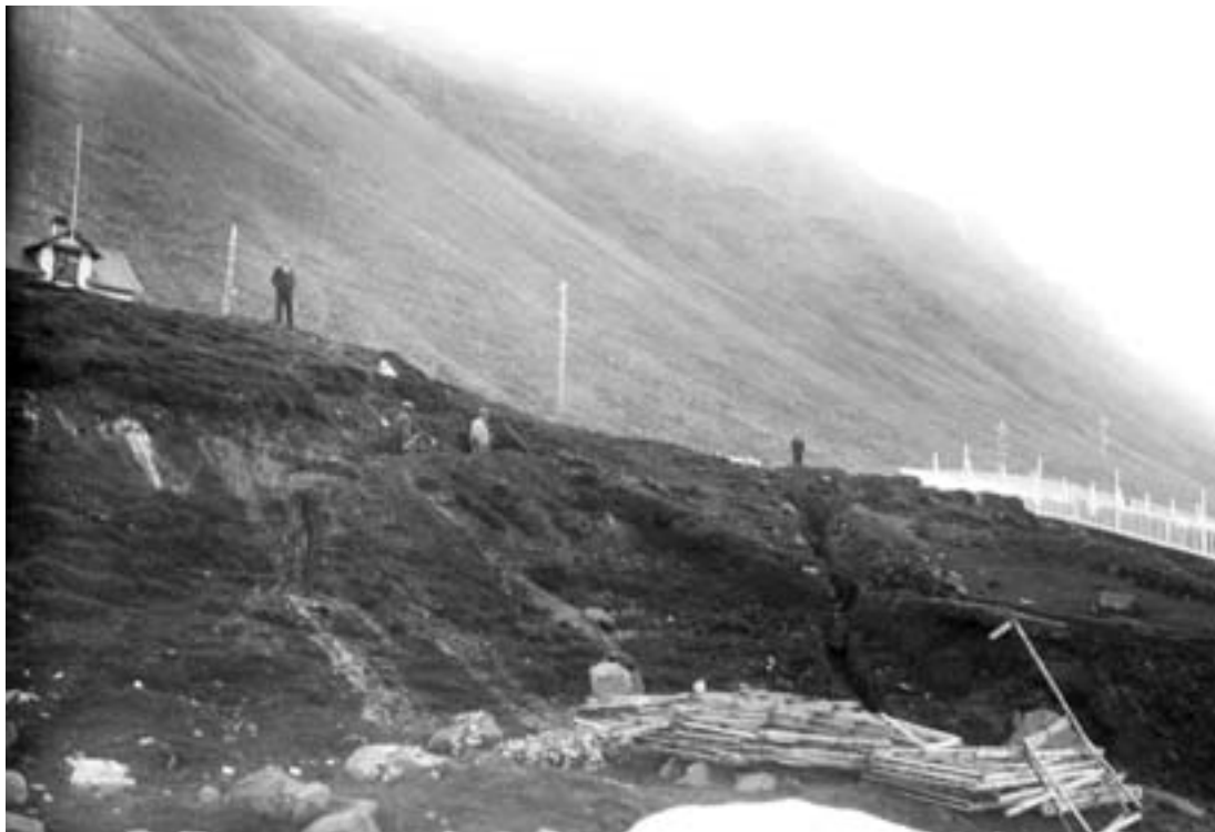
Unnið að stækkun garðsins árið 1930. Mynd: M. Simson (Skjalasafn Ísafjarðar)
