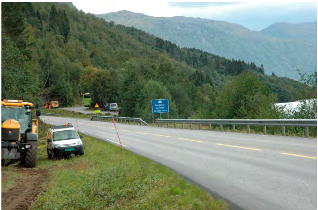
Gráelri við Konungsjarðgöngin við suðurbakka Hornindalsvatns í Sogn- og Fjarðarfylki. Mynd: ÁP
