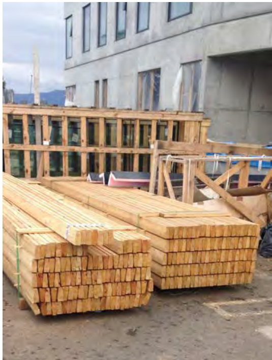
Lerki unnið hjá Skógarvinnslunni ehf á Viðivöllum í Fljótsdal var notað til klæðningar á Veröld, húsi Vigdísar Finnbogadóttur. Mynd: Bjarki M. Jónsson
