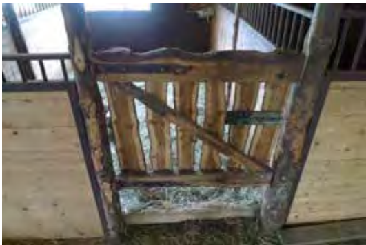
Heimasmíðaðar innréttingar í hesthúsinu í Kristnesi þar sem lerki úr eigin ræktun leikur burðarhlutverk enda sýna hrossin lítinn áhuga á að naga lerkið öfugt við aðrar viðartegundir. Mynd: EÖJ
