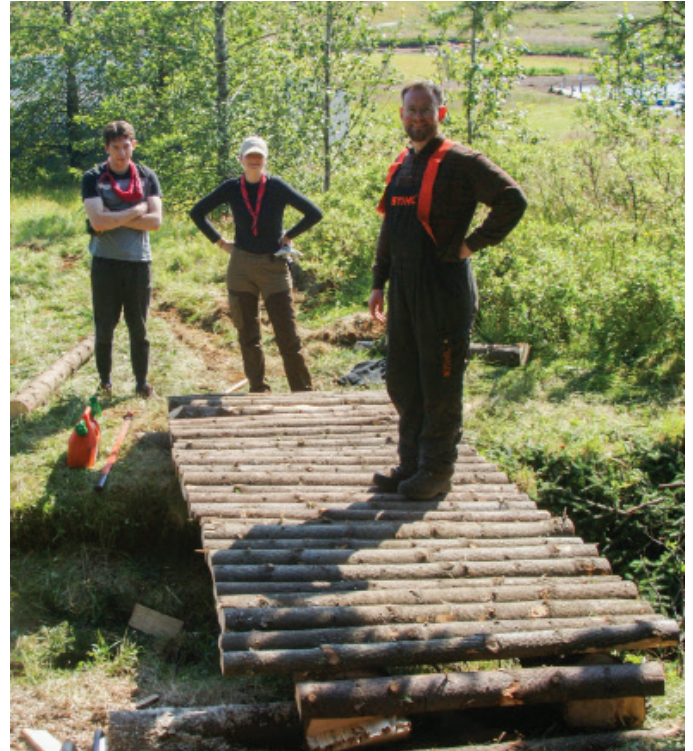
Meðal verkefna skátanna var að byggja brú úr trjábolum sem féllu til við grisjun í skóginum. Hringrásarhagkerfið í sinni tærustu mynd (Mynd: EB).
