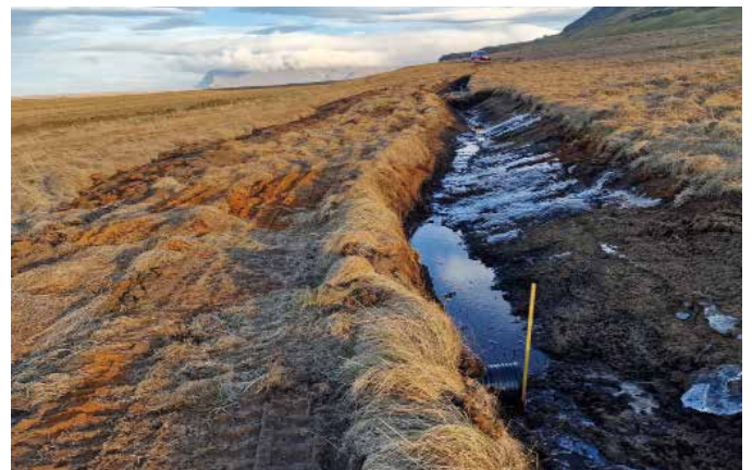
Búið að grafa djúpa vatnsrás neðst. Vatnsrásin grynngar smám saman þegar hærra kemur í landslagið. Torfur settar í stíginn og hann breikkaður. Neðst sett stórt vatnsrör, 20x6000 cm (Mynd: JBB).
