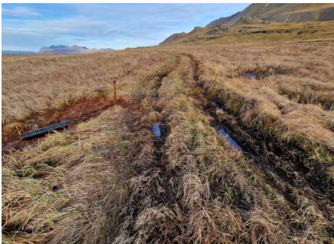
Einn stigurinn fyrir lagfæringar. Búið að lengja gamla frárennslisrörið en eftir að dýpka vatnsrásirnar og lagfæra stíginn (Mynd: JBB).
